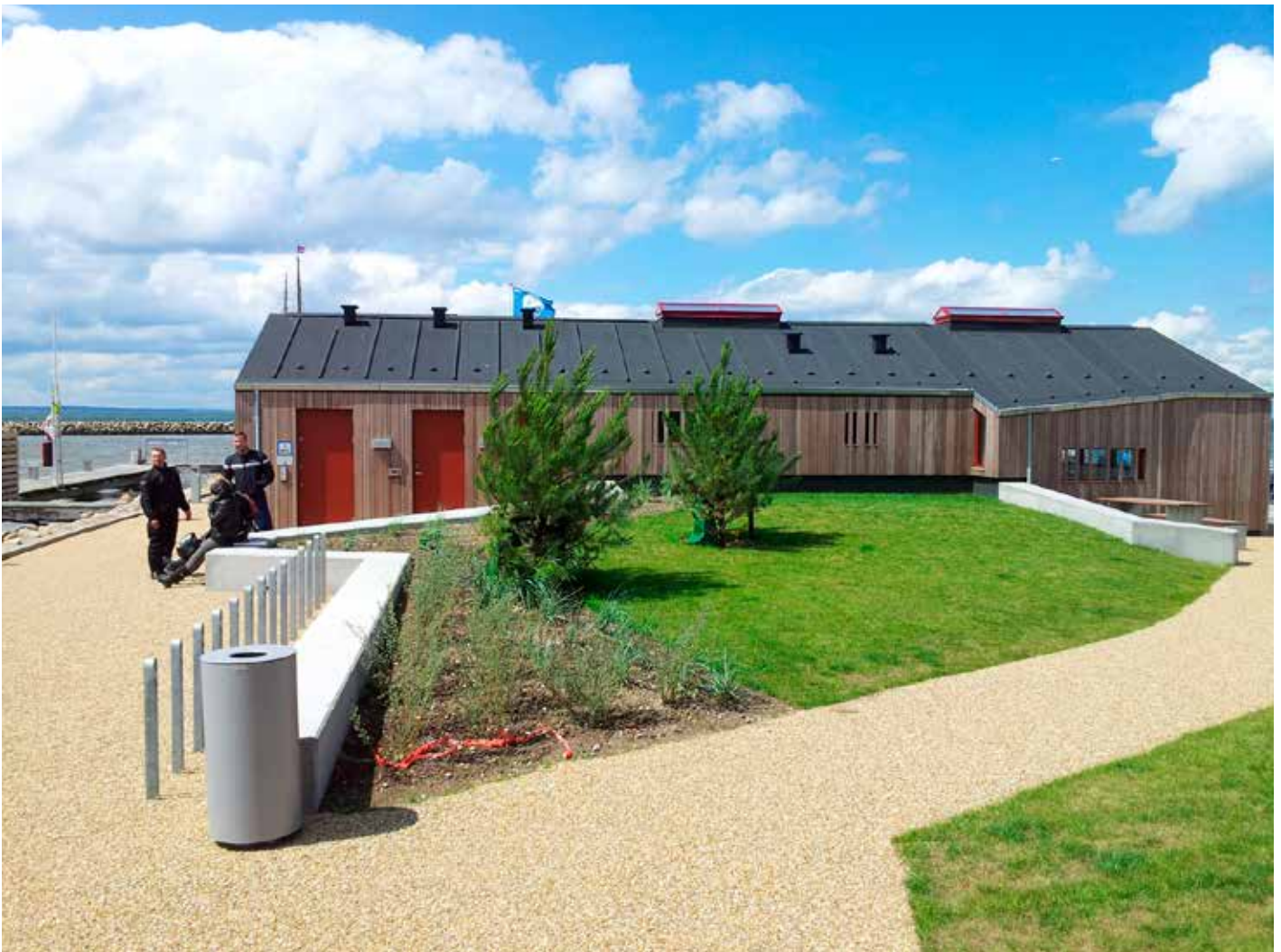
Det nye søbad i Bogense. Foto Jørn Elisiussen.
